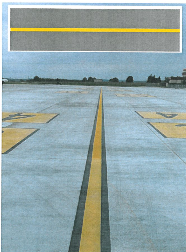
Oś drogi kołowania na nawierzchni betonowej
