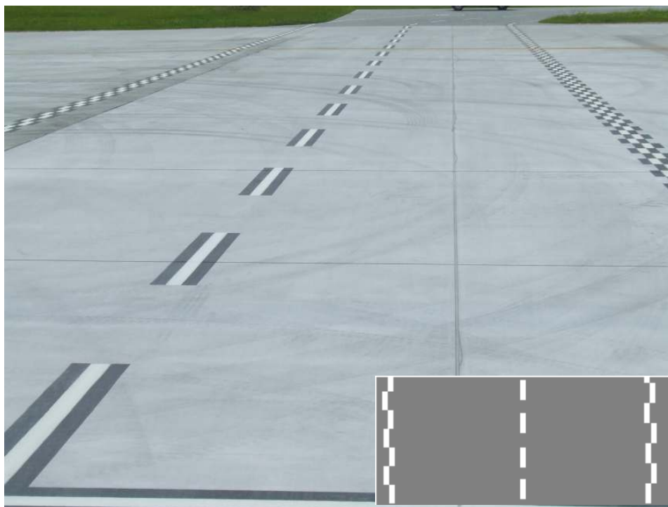
Droga serwisowa przecinająca drogę kołowania
