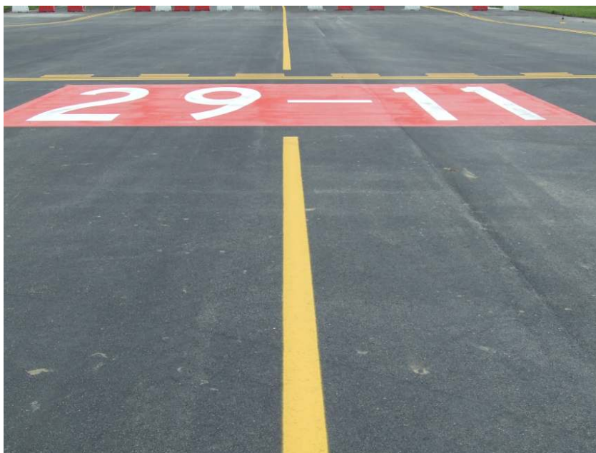
Oznakowanie nakazu – miejsce oczekiwania przed drogą startową.
