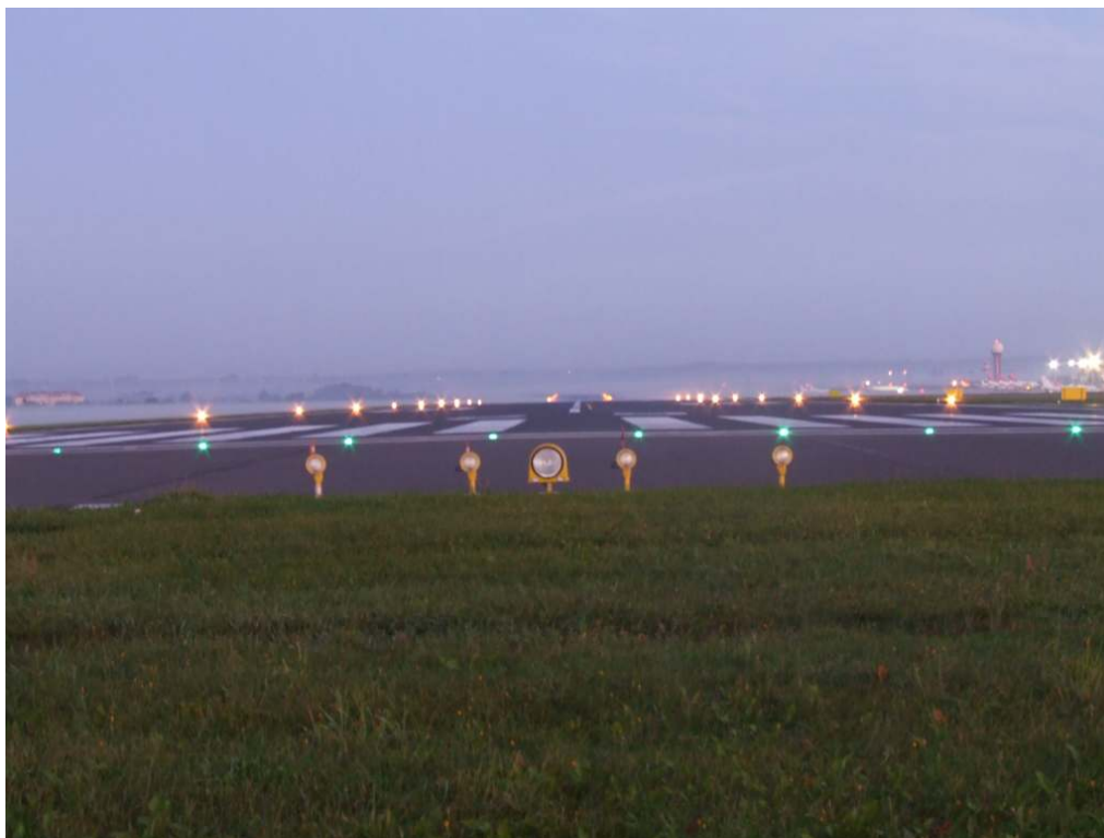
Zielone światła progu drogi startowej. W tle widoczne światła krawędziowe drogi startowej
