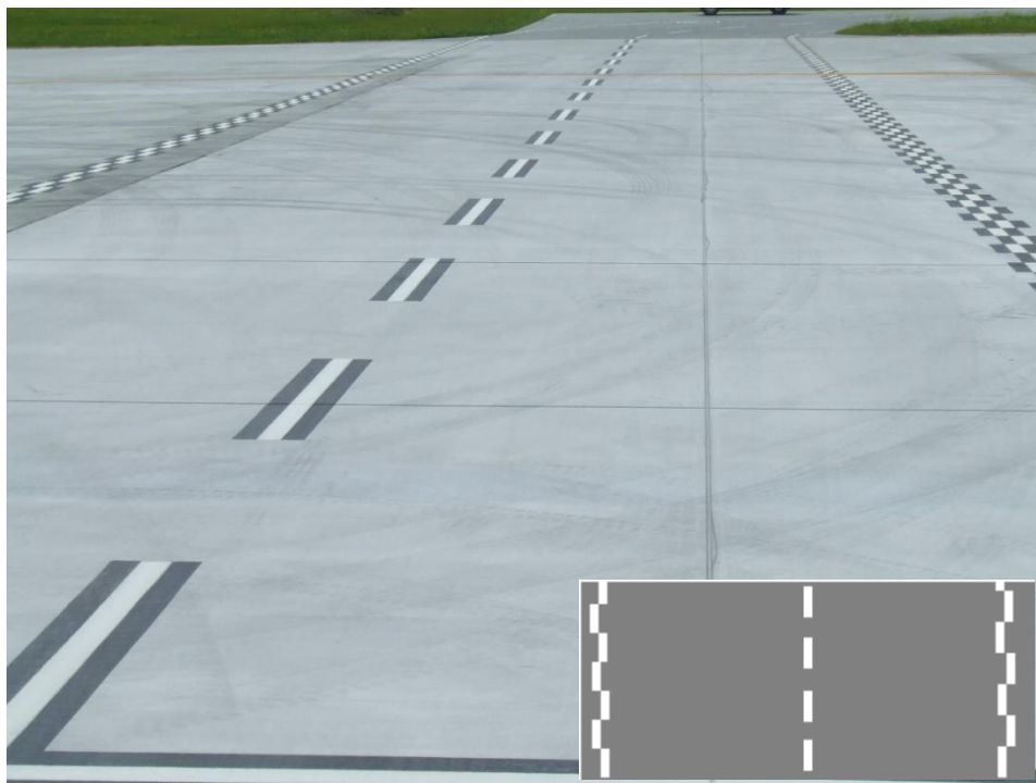
Droga serwisowa przecinająca drogę kołowania.
