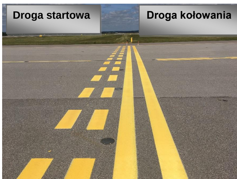
Oznakowanie poziome miejsca oczekiwania przed drogą startową w układzie A.
