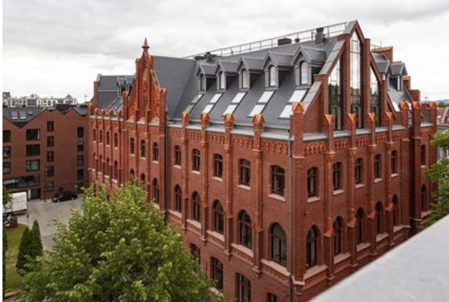
▲ W lipcu 2020 oddano do użytku dwa budynki przy ul. Lastadia – pod nr 2 i 41 (na zdjęciu nr 2, obecnie siedziba Gdańskiego Urzędu Pracy). Renowacja obu historycznych budynków została w konkursie. | Fot. Piotr Wittman/www.gdansk.pl
