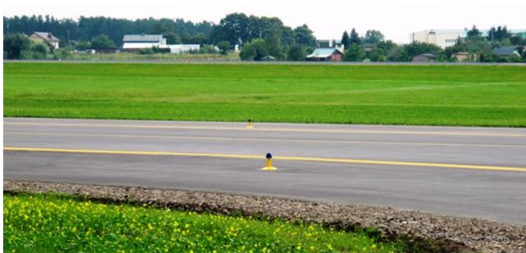
Oświetlenie krawędziowe dróg kołowania – niebieskie.
