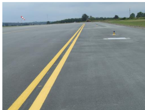
Krawędź drogi kołowania
