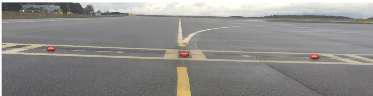
Oświetlenie poprzeczki zatrzymania
