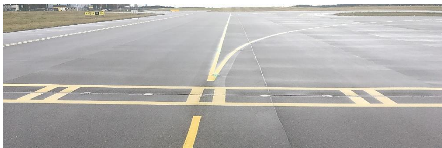
Oznakowanie poziome miejsca oczekiwania przed drogą startową w układzie B.
