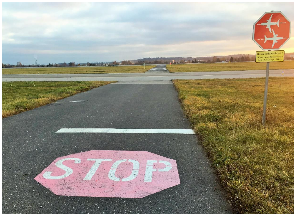
Znak i oznakowanie miejsca oczekiwania na drodze ruchu kołowego przed drogą kołowania.
