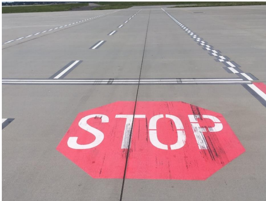
Oznakowanie STOP na drogach serwisowych.
