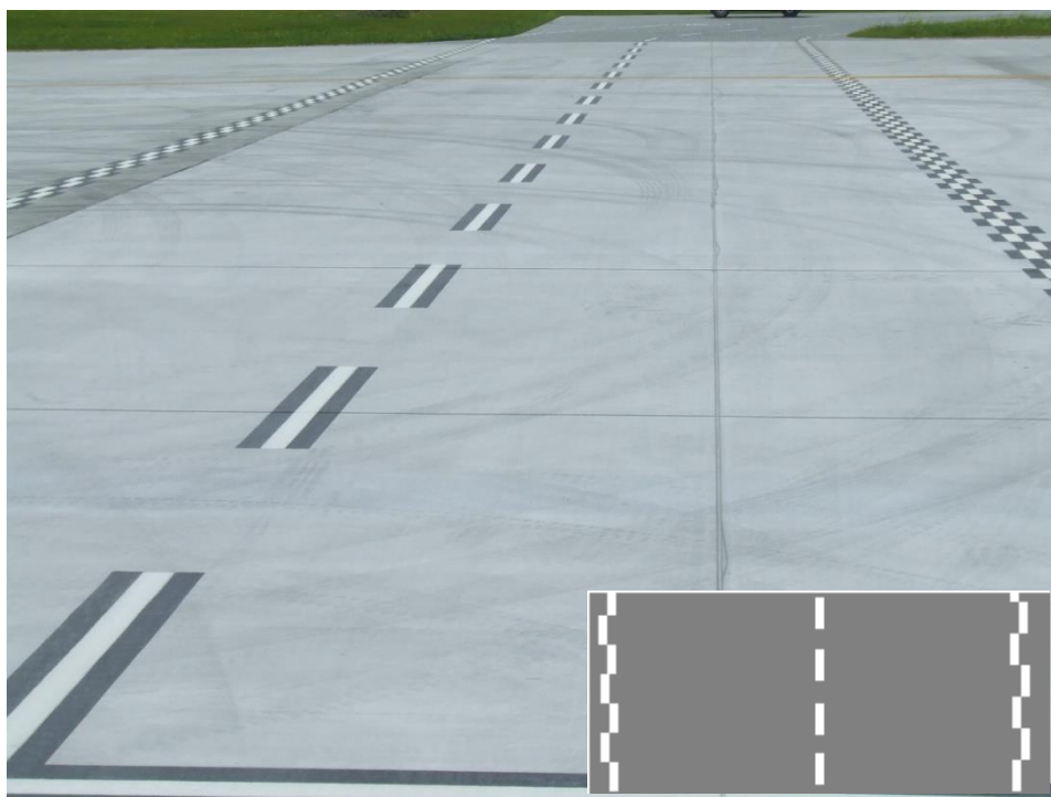
Droga serwisowa przecinająca drogę kołowania.
