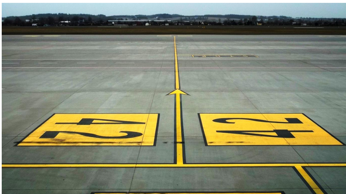
Oznakowanie poziome – stanowisko nr 42.
