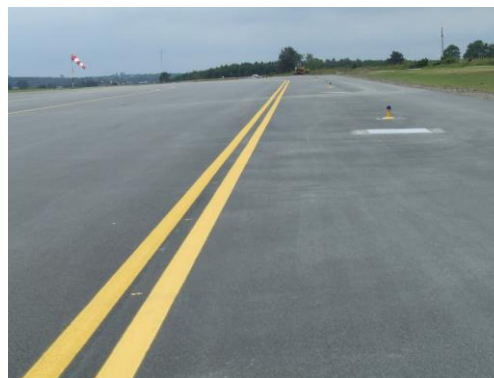
Krawędź drogi kołowania
