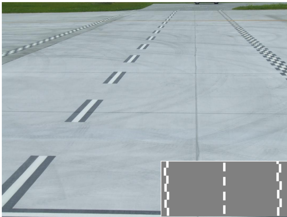
Droga serwisowa przecinająca drogę kołowania.
