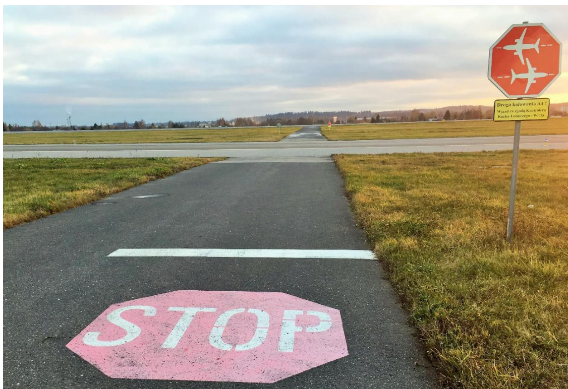
Znak i oznakowanie miejsca oczekiwania na drodze ruchu kołowego przed drogą kołowania.
