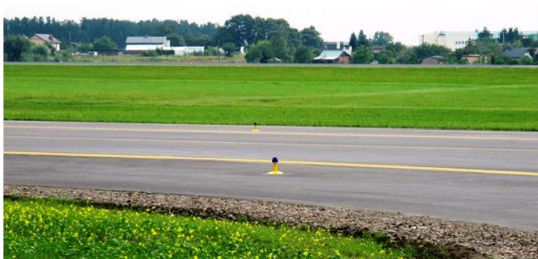
Oświetlenie krawędziowe dróg kołowania – niebieskie.
