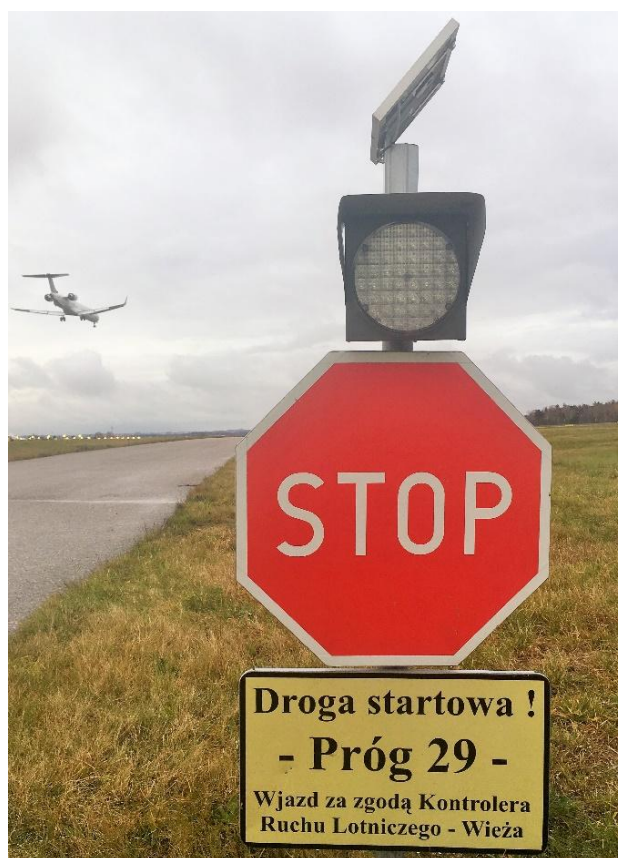
Znak i oznakowanie miejsca oczekiwania na drodze ruchu kołowego przed drogą startową.
