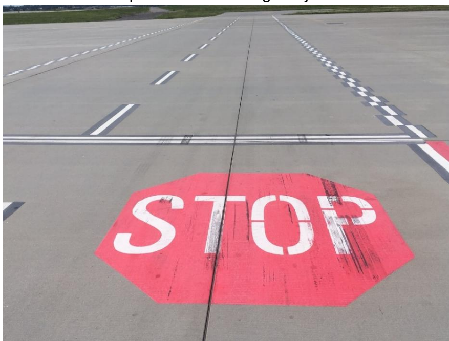
Oznakowanie STOP na drogach serwisowych.
